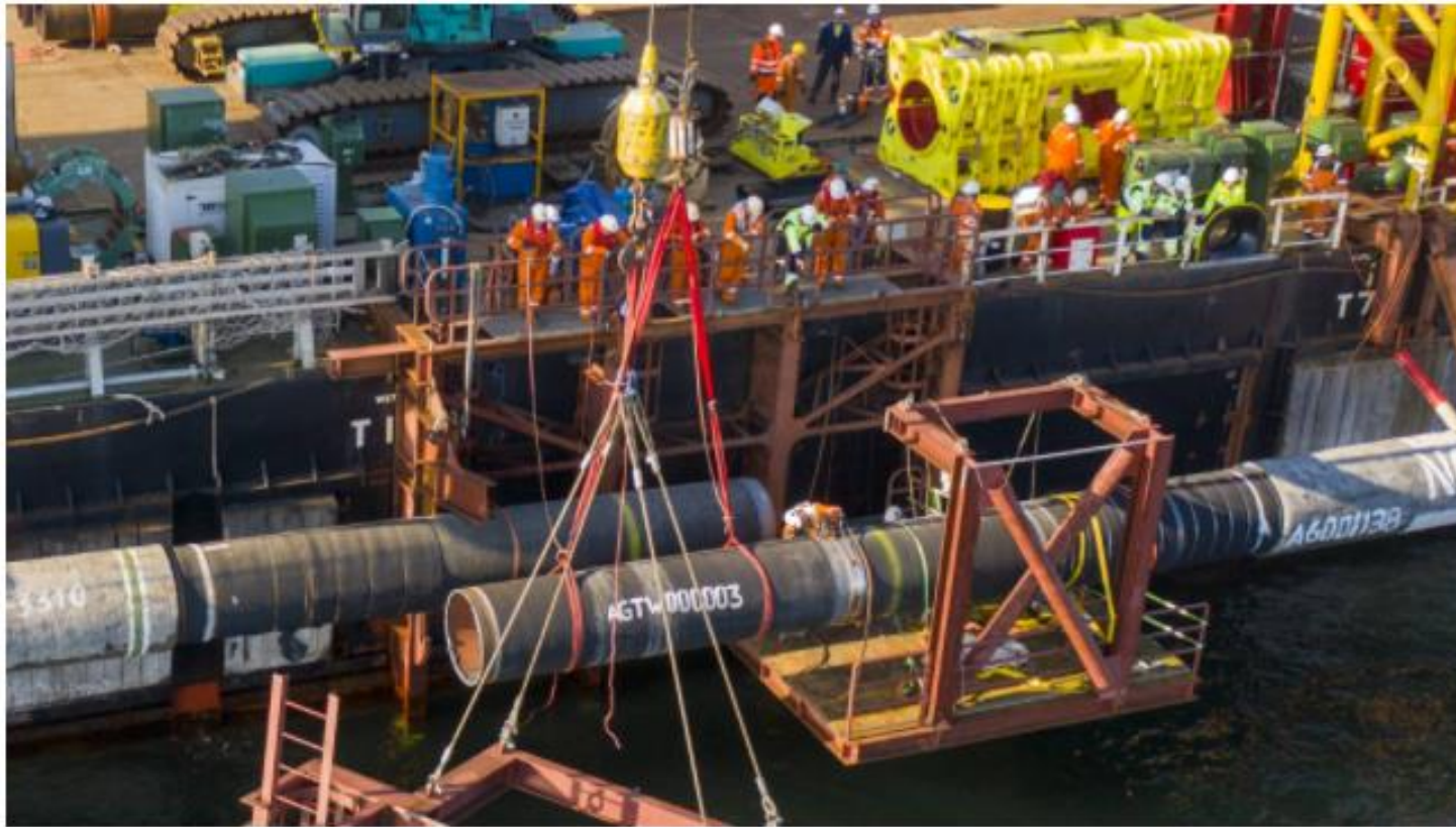
De aanleg van de Nord Stream2-gaslijn in de Oostzee AFP
