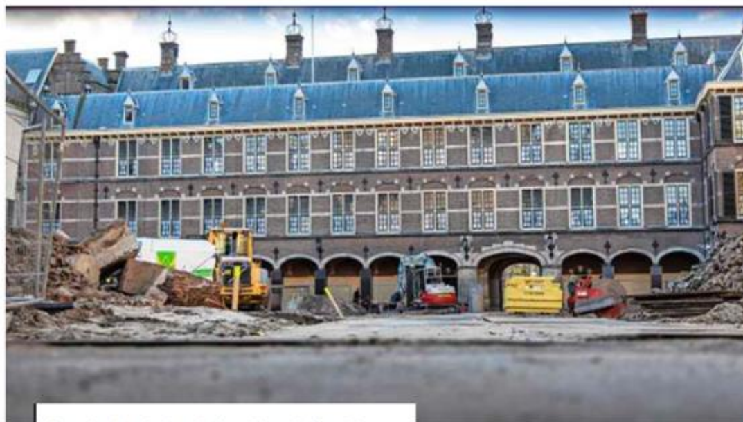
Renovatie werkzaamheden op het binnenplein van het Binnenhof.
