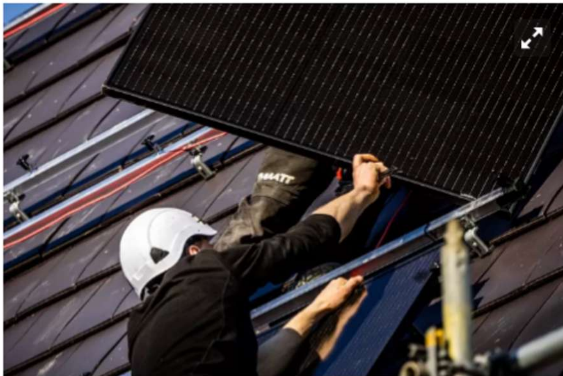
▲ Zonnepanelen worden gelegd op een woning. © Rob Engelaar
