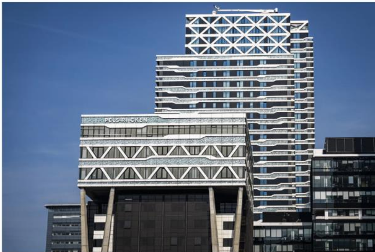
Het hoofdkantoor van advocatenkantoor Pels Rijcken in Den Haag.
