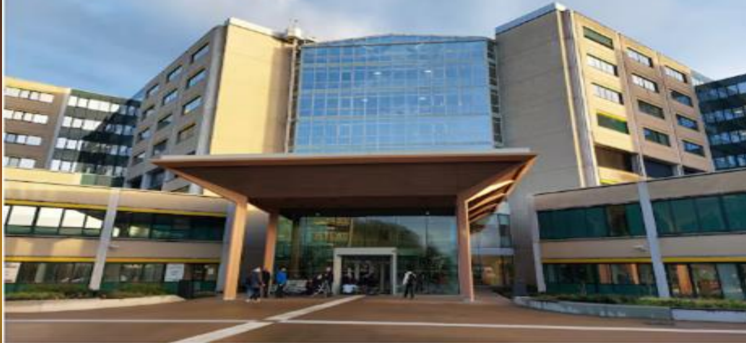
▲ Hoofdgebouw Rijnstate Arnhem. © DG
