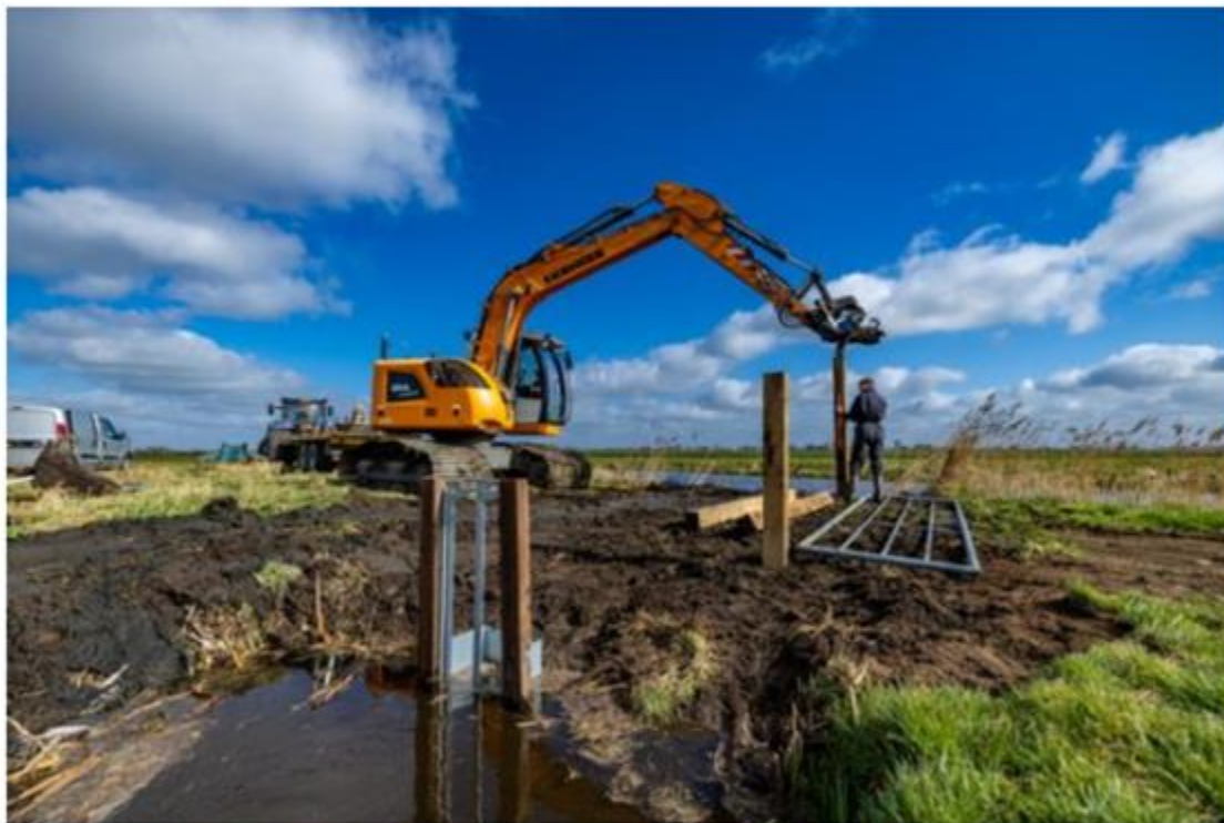
Het plaatsen van een stuw in één van de sloten bij Nes-Aldrum. Foto: Binne Louw Katsma
