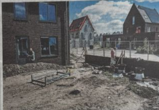
Nieuwbouwproject 'Breezicht' in Zwolle, met huur- en koopwoningen.
