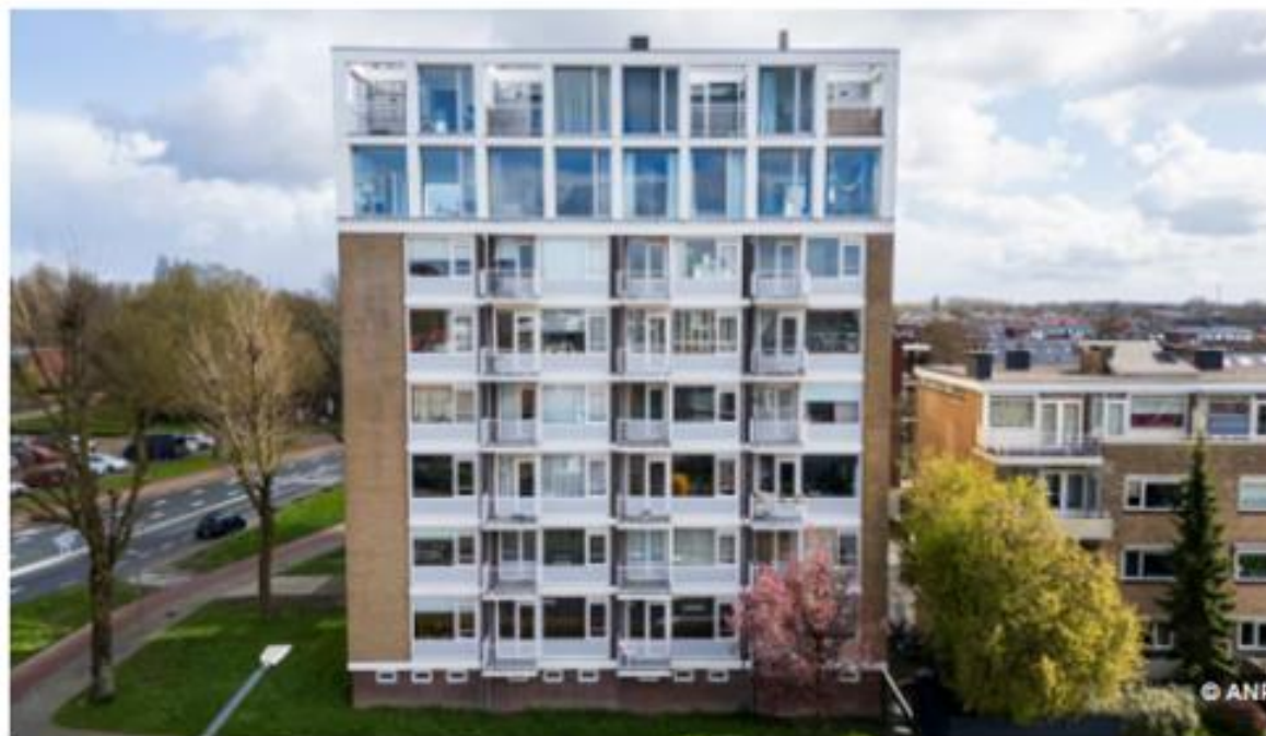
Een opgetopt appartementencomplex in Dordrecht.
